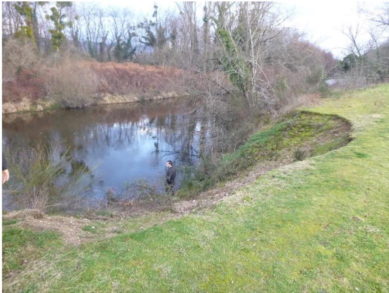
Figure 17 : Vue de l'encoche d'érosion de Moëras (commune de Peschadoires)
