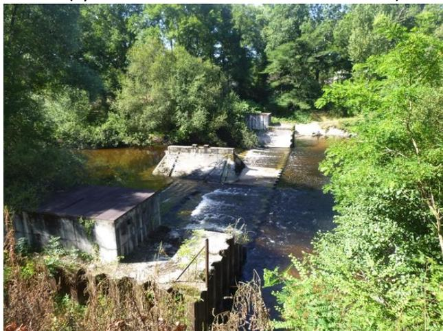
**Constitution** : l'ouvrage est bétonné jusqu'à la cote fond (288,26 NGF). Il présente 2 massifs béton latéraux et une pile centrale d'environ 6 m de large en base. Une enceinte de palplanches métallique ancrée sur la marne compacte (286,16 NGF) fait office de fondation et de dispositif parafouille. L'ouvrage ne semble pas présenter de désordre structurel majeur.
